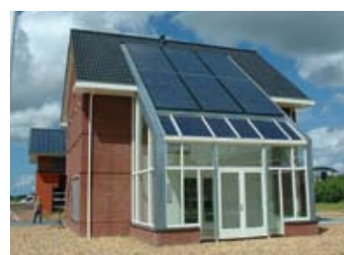
Bovenrij: PV Twin (3 x 5,6 m 2 ) Midden: PV laminaten (16,8 m 2 )
